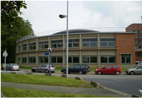
« Bâtiment J&K – Pôle Recherche »
